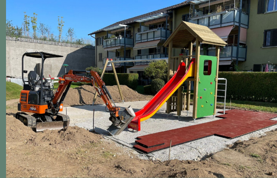
Bauarbeiten Spielplatz Siedlung 2
